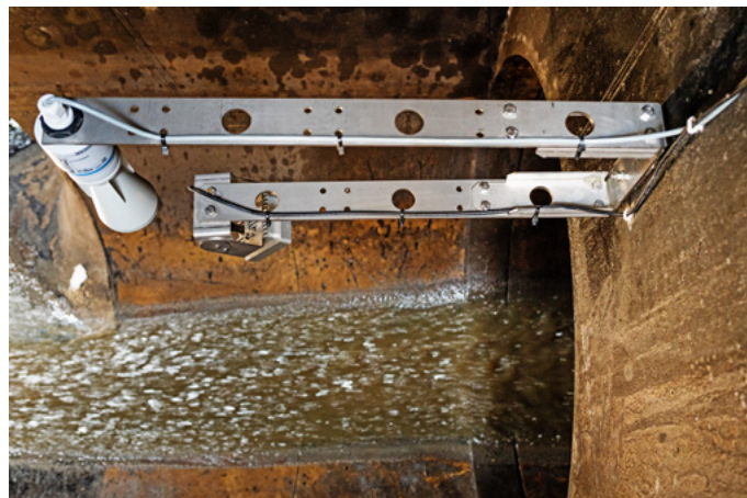
Stacja monitorowania przepływu i poziomu w kanale.
