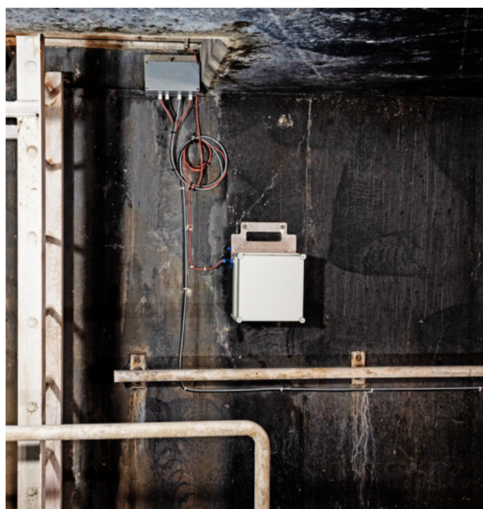
Układ zasilania stacji pomiarowej.
