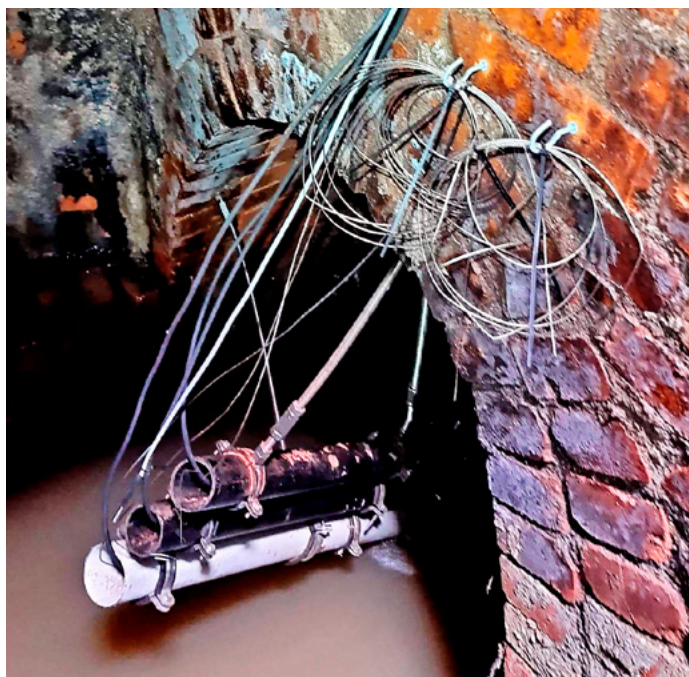
Czujniki umieszczone w armaturze ze stali nierdzewnej o klasie szczelności IP 68.
