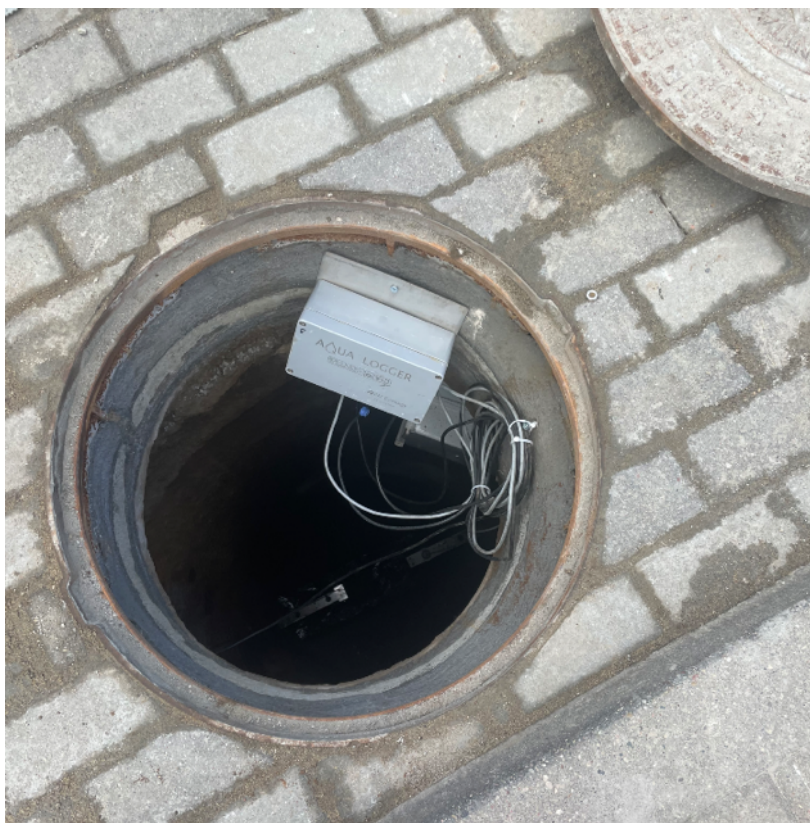
Zdjęcie 2. Moduł centralny urządzenia. Bezpośrednio poniżej widoczny akumulator w obudowie zabezpieczającej.
