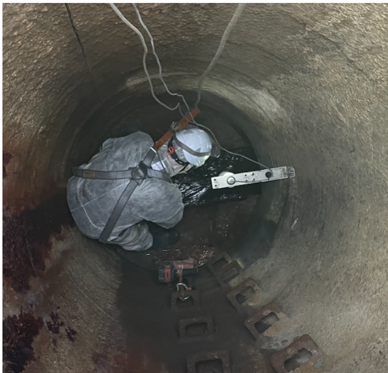
Zdjęcie 1. Instalacja urządzenia
