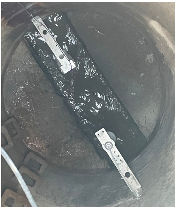
Zdjęcie 3. Sondy urządzenia wewnątrz komory.
