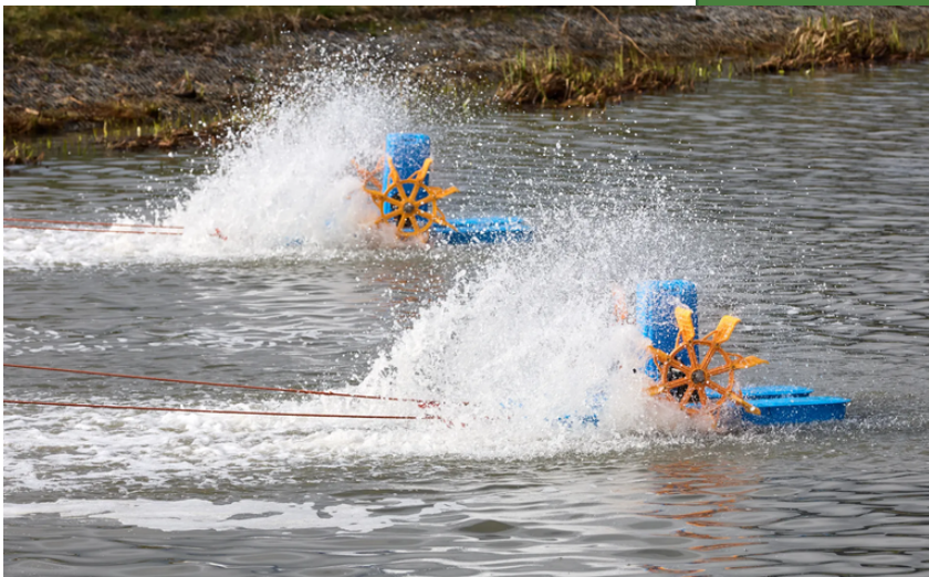
Fotografia przedstawia zbiornik retencyjny podczas procesu napowietrzania przez aeratory.
